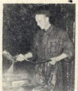
Lakierowanie części motocykla przy użyciu pistoletu pneumatycznego odbywa się bardzo szybko.
