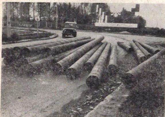
Wylamując pięć podpór, 20 potężnych rur spadło na jezdnię.
