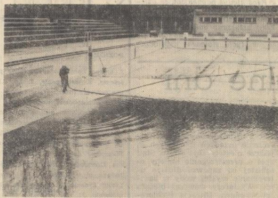
Do niedawna trwał tu remont...
