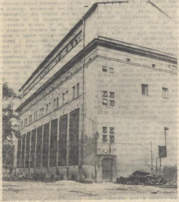
Budynek kotłowni z zewnątrz...
