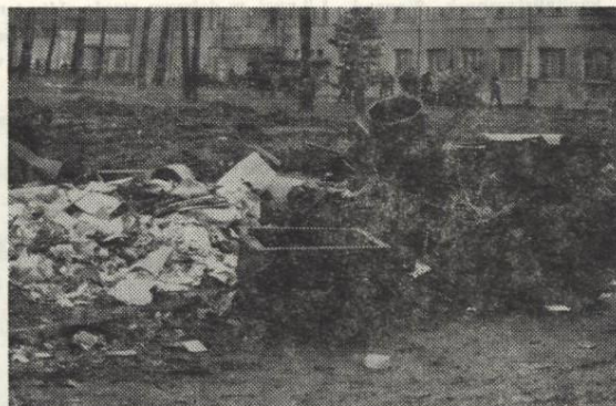
Przedpole hali nr 3 (na przeciwko wydziałów motocyklowych). To miejsce tak wyglądało jeszcze w latach sześćdziesiątych.
